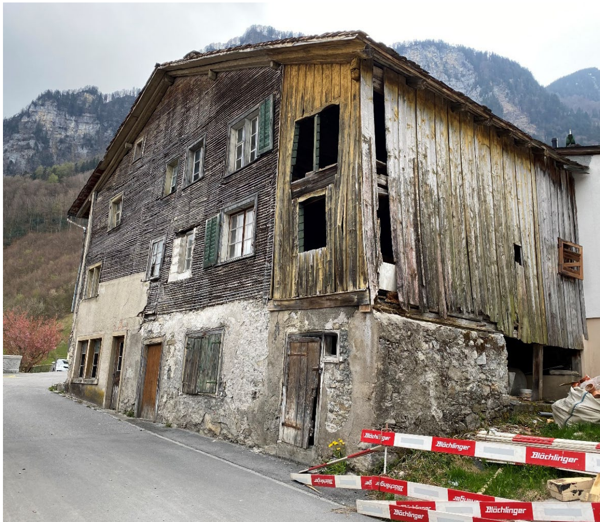
Bohlenständerbau Rüststrasse 2 in Oberurnen, Glarus Nord, 1409/10d. Foto: Miriam Derungs
